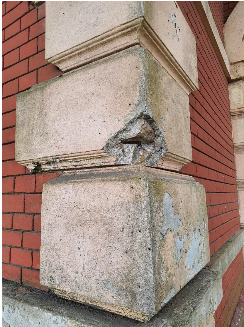
FOTO 05: Desprendimento do emboçamento de elemento ornamental da fachada.
