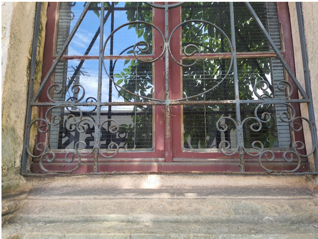
FOTO 06: Corrosão das grades de ferro.
