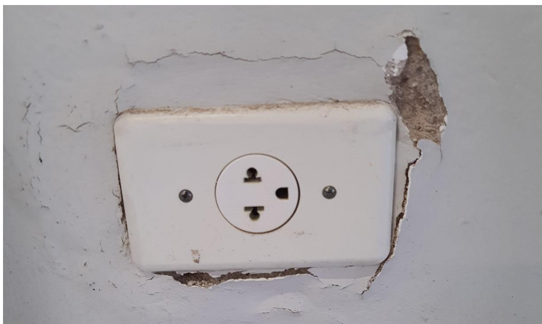
FOTO 13: Indício de ação da umidade no sistema elétrico.
