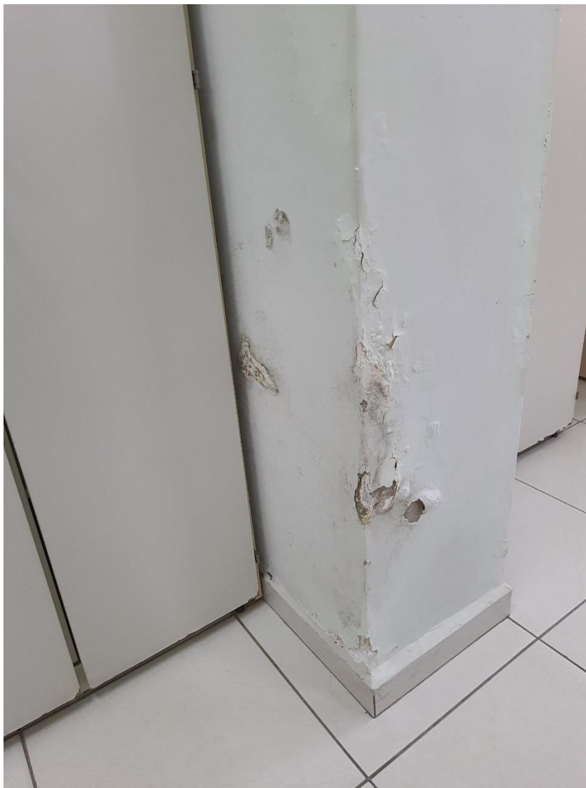
FOTO 11: Sinais de infiltração ascendente no térreo.
