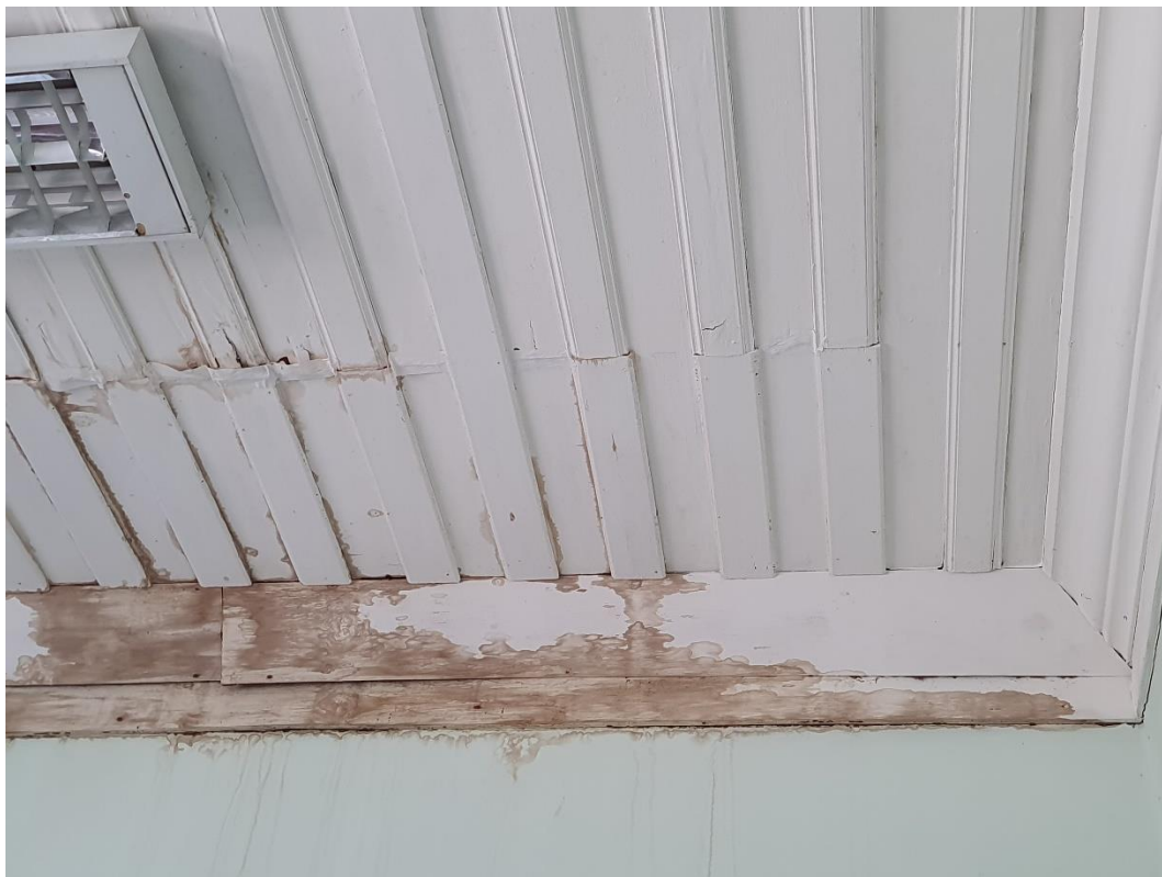
FOTO 16: Sinais de infiltração no forro.
