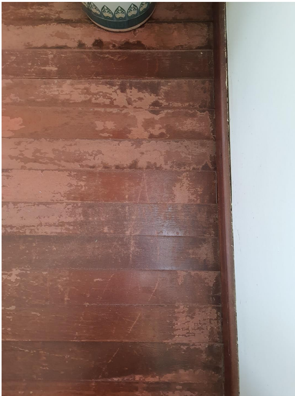
FOTO 20: Assoalho de madeira com acabamento desgastado.
