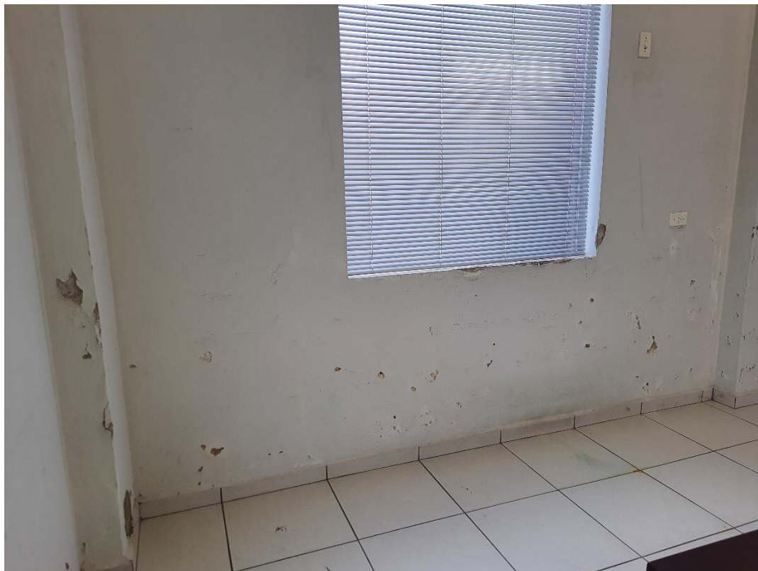
FOTO 12: Sinais de infiltração ascendente no térreo.
